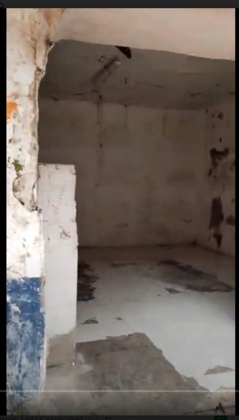
Imagen 8 y 8ª: Celda dos (2) primer piso
