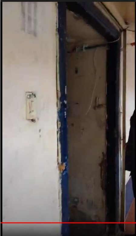
Imagen 17: Celda No 10 segundo piso puerta de corredera.
