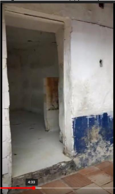
Imagen 12: Celda cinco (5) primer piso
