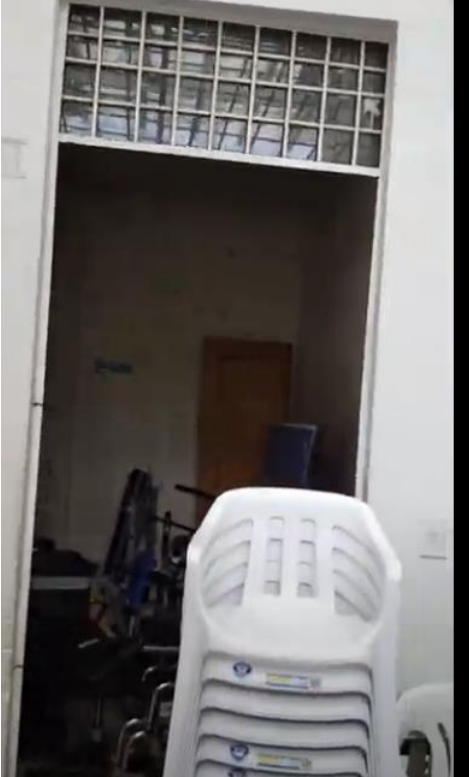
Imagen 19: Puerta metálica área interna - actualmente bodega
