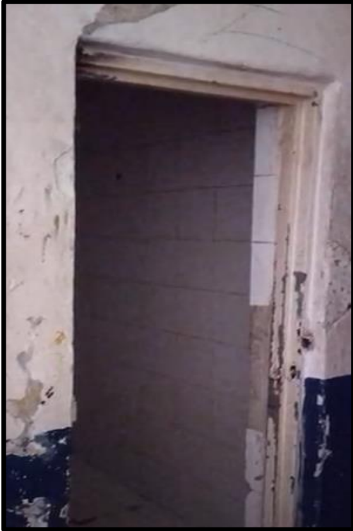
Imagen 15: Baño habilitado para visitas de segundo piso
