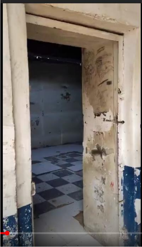
Imagen 9: Celda uno (1) primer piso
