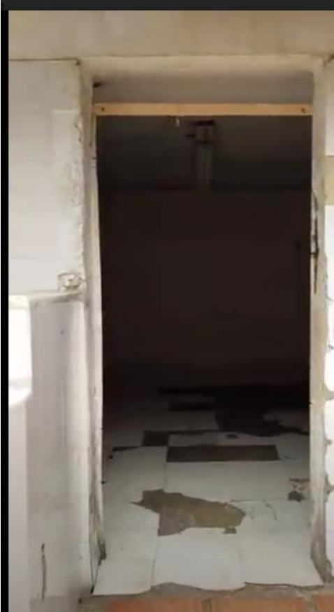
Imagen 11: Celda (6) primer piso
