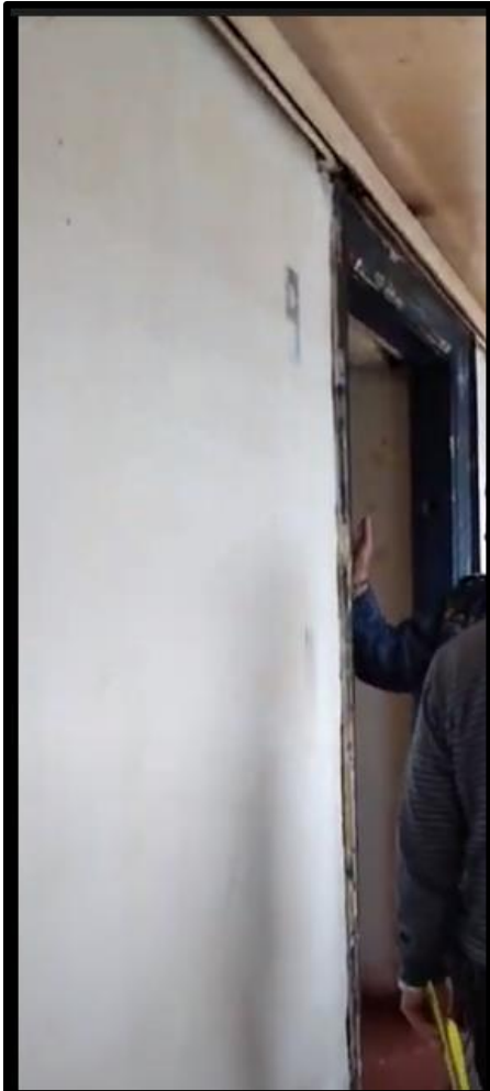
Imagen 18: Celda No 9 segundo piso reja de corredera
